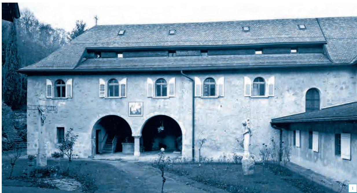
1 Façade sud de l'aile nord. Photo: © Etat du Valais / PBC; photographie: Jean Pot.
