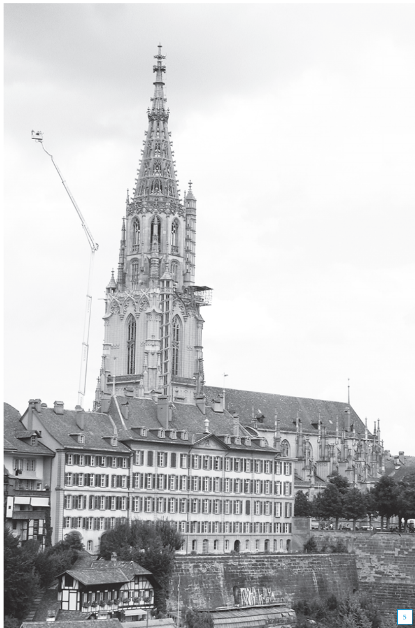
5 Fotogrammetrische Aufnahmen am Berner Münster von einer Hebebühne mit bis zu 84 m Reichweite aus. Foto: Berner Münster-Stiftung.
