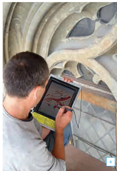
8 Rechts: Der Betriebsleiter der Münsterbauhütte, Peter Völkle, kartiert Schäden auf fotogrammetrischen Plänen direkt am Tablet-PC.
