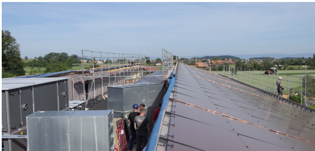
▲ Montage de l'installation photovoltaïque. © OFPP
