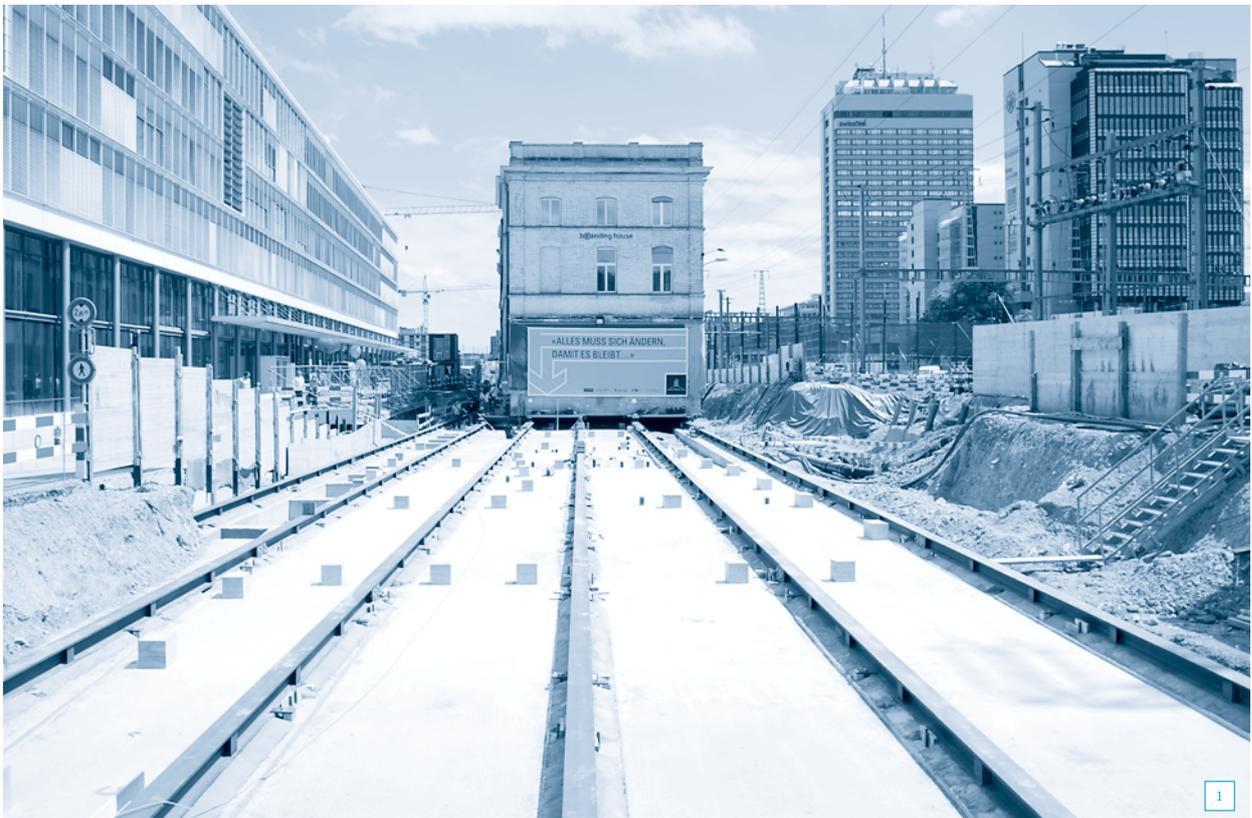
wenn es mobilisiert wird. 2011 wurde das ehemalige Verwaltungsgebäude der Maschinenfabrik Oerlikon (MFO) in Zürich Oerlikon verschoben. Die Reise war zwar nach nur 60 Metern zu Ende, sie beförderte das 6200 Tonnen schwere und 80 Meter lange Gebäude aber aus dem Perimeter des SBB-Gleisbereichs und rettete es so vor der sicheren Zerstörung. Vor Ort wurde die Gebäudeverschiebung von zahlreichen Zuschauern verfolgt und das Schweizer Fernsehen übertrug
