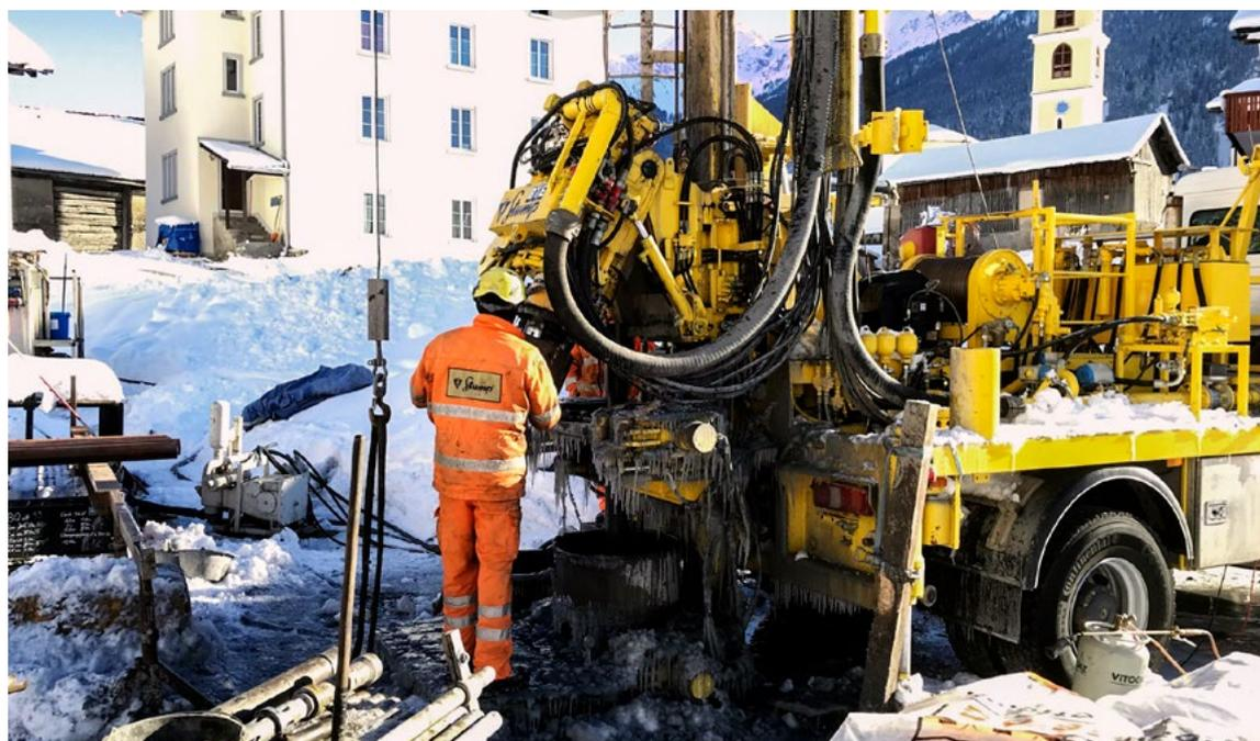
**Carottages à Brienz/Brinzauls. Les forages de même que des examens sismiques et géoélectriques ont pour but de suivre l'évolution des couches géologiques du sol.**
