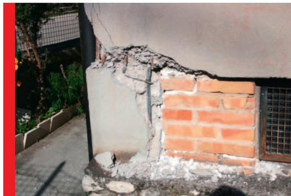
**Photo 12**Déformation plastique de l'armature: *DD3*
