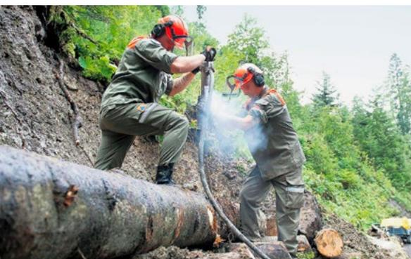
Engagée en terrain raide et glissant, la protection civile stabilise les pentes: vissage des troncs d'arbre avec des fers d'armature.
